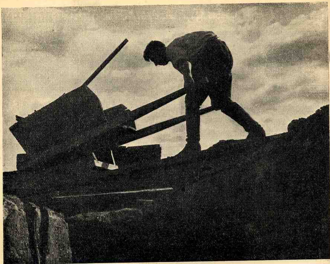
На земляных работах
