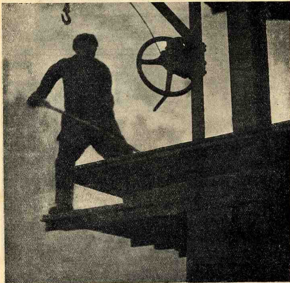
ВАРКА СМОЛЫ НА АСФАЛЬТОВОЙ МАШИНЕ
