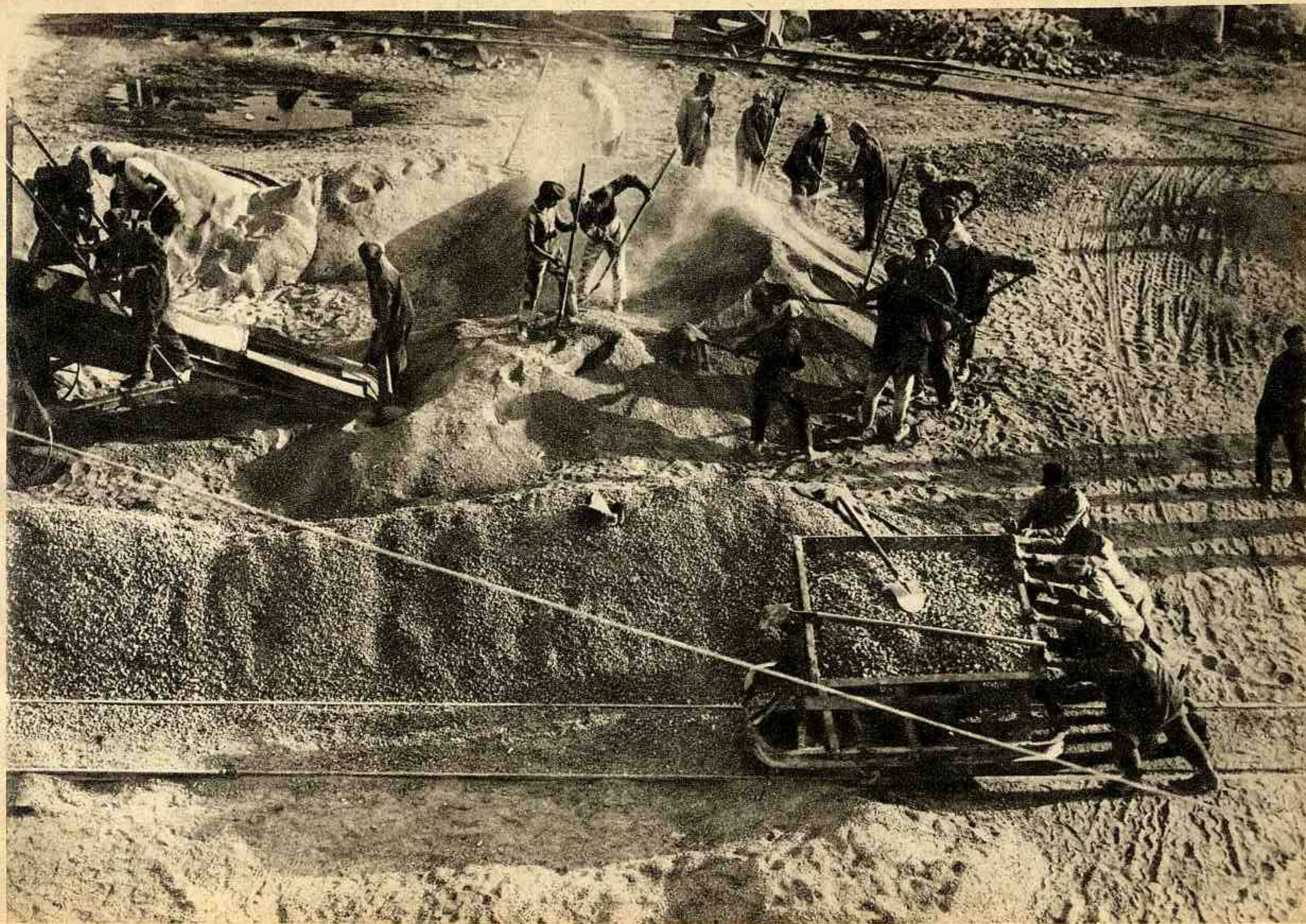
НА АСФАЛЬТОВОМ ЗАВОДЕ
